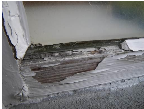
Geschädigter Kittfalz
