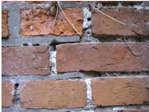
Ausbrechende Zementmörtelfugen
