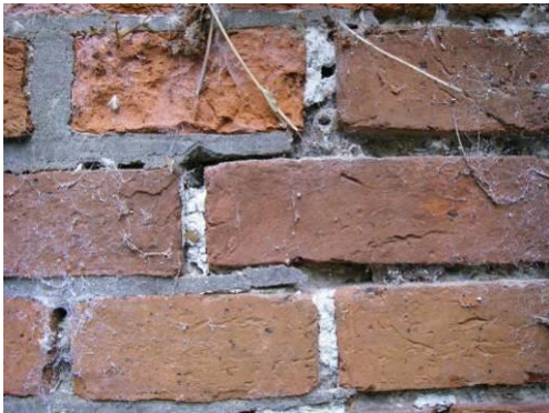
Ausbrechende Zementmörtelfugen
